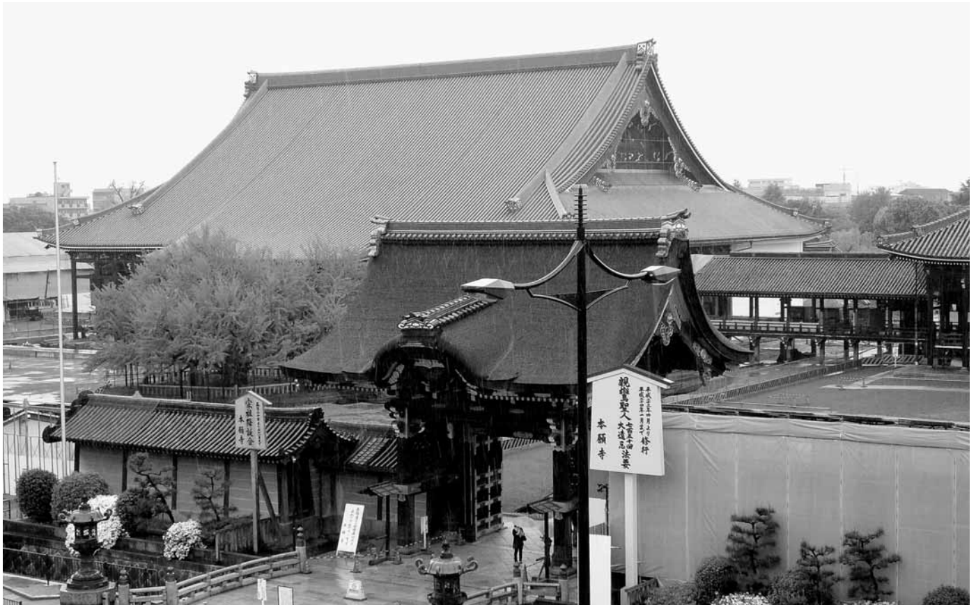
本山御影堂（仮屋根が取れて 新しく・・・）
